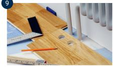
Wenn die lange Seite der Platte auf ein Rohr trifft, bohren Sie ein Loch mit einem Durchmesser, der mindestens 16 mm größer ist als der Durchmesser des Rohrs, so dass eine Dehnungsfuge um das Rohr entsteht. Mit einem Bleistift markieren, wo gesägt werden soll.
