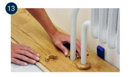
Die Diele montieren, das lose Teil festkleben, einen Keil an die Wand legen und mit Rohrmanschetten abdecken.
