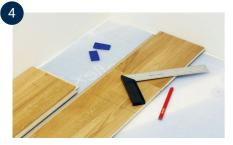
Am Ende der Reihe die letzte Diele so drehen, dass die Nutseite an der Nutseite anliegt. Drücken Sie das kurze Ende fest gegen die Wand. Markieren Sie den Schnitt mit einem Bleistift, mindestens 8–10 mm vom kurzen Ende des vorherigen Bretts entfernt, damit Sie beim Einsetzen des Bretts eine Dehnungsfuge haben.
