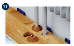
Diele anschlagen, loses Stück aufkleben, einen Keil an die Wand legen und mit Rohrmanschetten abdecken.
