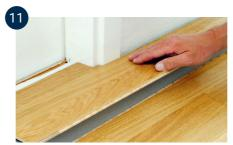
Dann die letzte Diele von der Seite mit einem Schlageisen verlegen. Zum Schluss platzieren Sie Keile in der Dehnungsfuge zwischen Boden und Wand, so dass der Boden unter Spannung steht, bis der Klebstoff getrocknet ist. Nachdem der Boden verlegt ist, können Leisten und Sockelleisten angebracht werden; vergessen Sie jedoch nicht, alle Keile zu entfernen.
