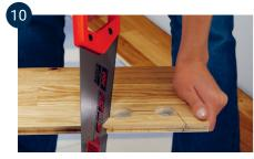
Sägen Sie das Stück ab, das hinter den Rohren und am nächsten zur Wand platziert werden soll. Schneiden Sie schräg, wie in der Abbildung gezeigt. Befindet sich das Rohr an der kurzen Seite des Bodens, muss die Diele in einem 90°-Winkel gerade durch die Löcher geschnitten werden.
