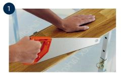
Bevor Sie die erste Reihe verlegen, müssen Sie den Überstand an der Federseite abschneiden.
