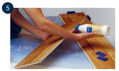
Erste Diele, zweite Reihe. Beginnen Sie mit der abgeschnittenen Diele aus der ersten Reihe. Beachten Sie, dass über den gesamten Boden ein Abstand von mindestens 500 mm an den Endfugen eingehalten werden muss (mindestens 300 mm bei Dielen mit einer Länge von < 1.250 mm). Dies gilt nicht für Start- und Stoppdielen.
