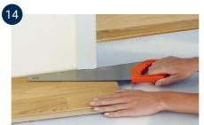
Türverkleidungen können entfernt und nach oben bewegt werden, lassen sich aber in der Regel leichter absägen. Verwenden Sie eine lose Bodendiele als Höhenschablone und sägen Sie die Verkleidung ab. Achten Sie darauf, dass der Boden nicht zwischen dem Unterboden und dem Rahmen eingeklemmt wird.
