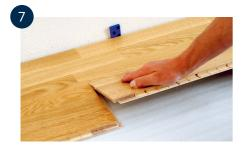
Klappen Sie die Diele in einer kontinuierlichen Bewegung nach unten und üben Sie dabei leichten Druck auf das kurze Ende der vorherigen Diele aus. Achten Sie beim Herunterklappen darauf, dass die Dielen eng beieinander liegen. Fahren Sie mit der Verlegung des Bodens wie zuvor beschrieben fort.
