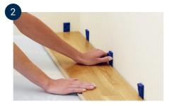
Erste Reihe. Denken Sie daran, dass die Dielen vorzugsweise in Längsrichtung des Raumes verlegt werden sollten. Beginnen Sie in einer linken Ecke mit der Federseite an der Wand und arbeiten Sie sich nach rechts vor. Drücken Sie Keile zwischen Boden und Wand nach unten, um eine Dehnungsfuge von mindestens 8–10 mm zu schaffen.
