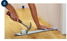
Abgesägte Diele mit dem Schlageisen einschlagen. Wenn die letzte Dielenreihe nicht abgeschnitten wurde, muss die Feder abgeschnitten werden, damit die Dehnungsfuge nicht verschwindet.
