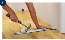
Abgesägte Diele mit dem Schlageisen einschlagen. Wenn die letzte Dielenreihe nicht abgeschnitten wurde, muss die Feder abgeschnitten werden, damit die Dehnungsfuge nicht verschwindet. Legen Sie auch Keile auf die letzte Dielenreihe. Lassen Sie die Keile ein paar Stunden lang an Ort und Stelle (z. B. über Nacht), bevor Sie sie entfernen.
