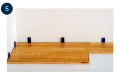
Erste Diele, zweite Reihe. Beginnen Sie mit der abgeschnittenen Diele aus der ersten Reihe. Beachten Sie, dass über den gesamten Boden ein Abstand von mindestens 500 mm an den Endfugen eingehalten werden muss (mindestens 300 mm bei Dielen mit einer Länge von < 1.250 mm). Dies gilt nicht für Start- und Stoppdielen.
