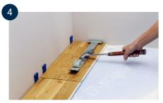
Schneiden Sie dann die Diele ab. Kleben Sie das kurze Ende fest, schieben Sie die Diele an ihren Platz, schlagen Sie sie mit dem Tarktool Schlageisen zusammen und befestigen Sie einen Keil am kurzen Ende an der Wand.
