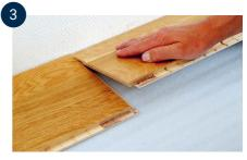
Zweite Diele, erste Reihe. Diese Diele vorsichtig in der Nähe des kurzen Endes der ersten Diele platzieren. Drücken oder klopfen Sie dann leicht auf das gerade verlegte kurze Ende.
