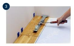
Schneiden Sie dann die Diele aus, schieben Sie sie an ihren Platz, schlagen Sie sie mit dem Tarktool Schlageisen zusammen und befestigen Sie einen Keil am kurzen Ende an der Wand.
