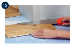
Türverkleidungen können entfernt und nach oben versetzt werden, aber es ist meist einfacher, sie abzusägen. Verwenden Sie eine lose Diele als Höhenschablone und sägen Sie die Verkleidung mit einer fein gezahnten Säge ab. Schieben Sie den Boden unter die Verkleidung. Achten Sie darauf, dass der Boden nicht zwischen dem Untergrund und der Auskleidung eingeklemmt wird.
