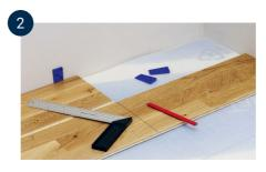
Am Ende der Reihe die letzte Diele so drehen, dass die Feder an der Feder anliegt. Drücken Sie das kurze Ende fest gegen die Wand. Markieren Sie den Schnitt mit einem Bleistift, mindestens 8–10 mm vom kurzen Ende der vorherigen Diele entfernt, damit Sie eine Dehnungsfuge erhalten, wenn die Diele dann in Position geschoben wird.
